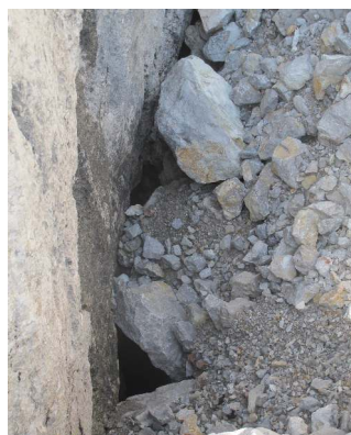
Situation des Einstiegs nach dem Felssturz, fotografiert am 19.7.2015 (Foto: R. Fischer).
