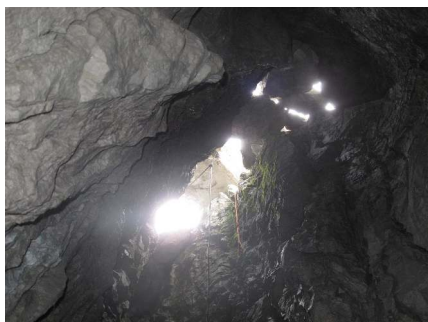
Bedrohlich wirkende Blocküberdeckung des Schneekarschachtes XXV (Foto: R. Fischer).
